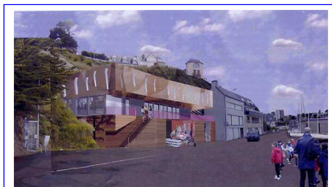
Le centre nautique vu depuis le quai Image extraite de la présentation du projet Hervé Potin et Anne-Flore Guinée, architectes, Nantes.
