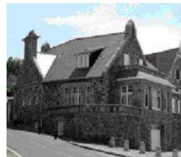
Élément de décor : pignons découverts couronnés d'un clocheton, encadrement des ouvertures et rampants des pignons appareillés de grès, effet de polychromie (granit et grès rose), porte d'entrée en anse de panier chanfreinée.
