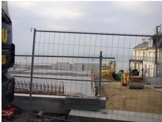
Etat du chantier à fin décembre côté rue du Jardin public.
